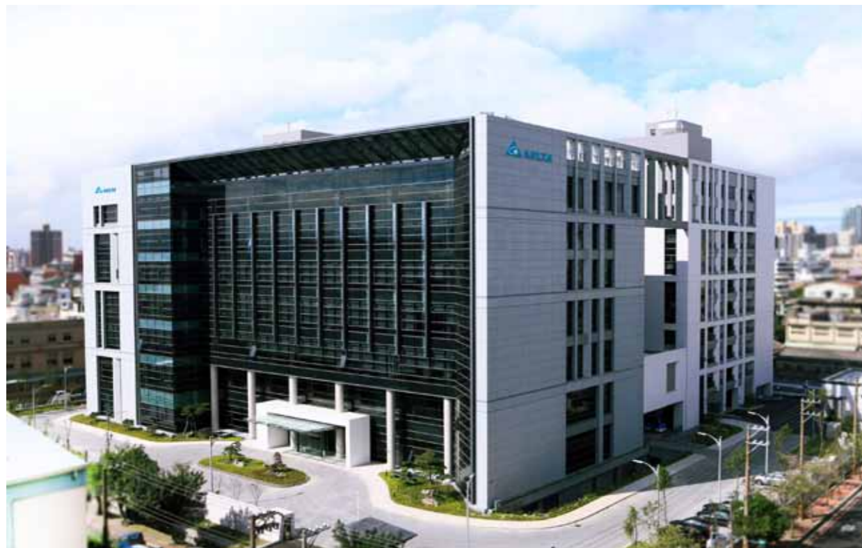
台達電子桃園研發中心是一棟智慧綠建築
