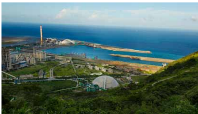
台泥於台灣東部之水泥、電力、港口三合一廠鳥瞰圖
